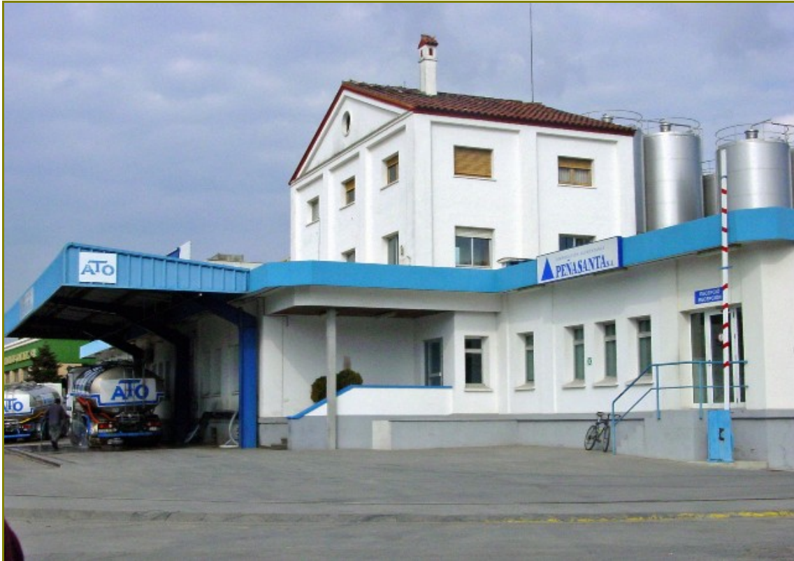
Façana principal de les instal·lacions a Vidreres
