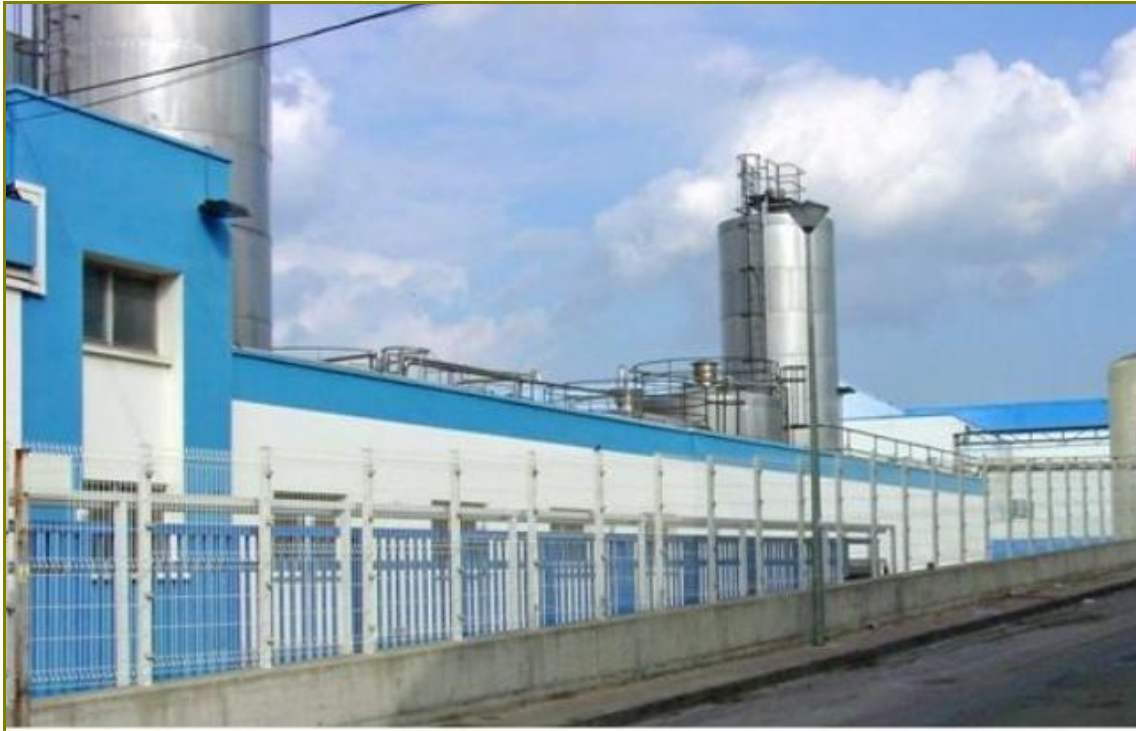
Vista lateral de la planta de Vidreres
