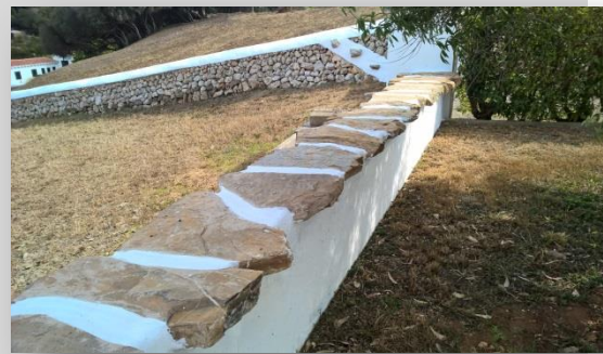
Paret rematada amb lloses
