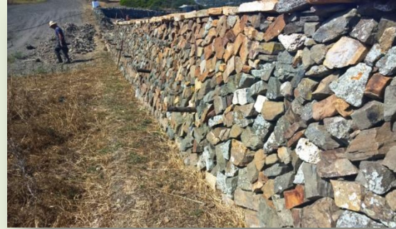
Paret acabada: base 1 m, alçada 1,40 m, amplada cobertora 0,45 m
