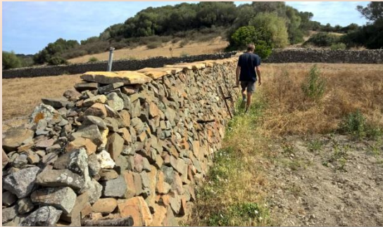
Reconstrucció de la paret
