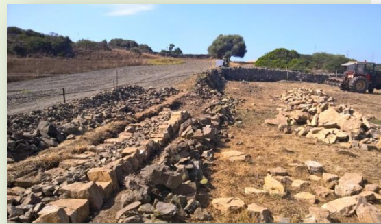
En la reconstrucció en primer lloc es posen les de la base (fonamentada), després les pedres grosses (fonament) i a continuació les filades. Els rebles omplen els buits.
