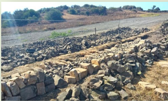
Es desmunten les diferents filades de la paret i s'amunteguen en fileres uniformes per destriar els rebles, els macs o còdols, les lloses, etc.
