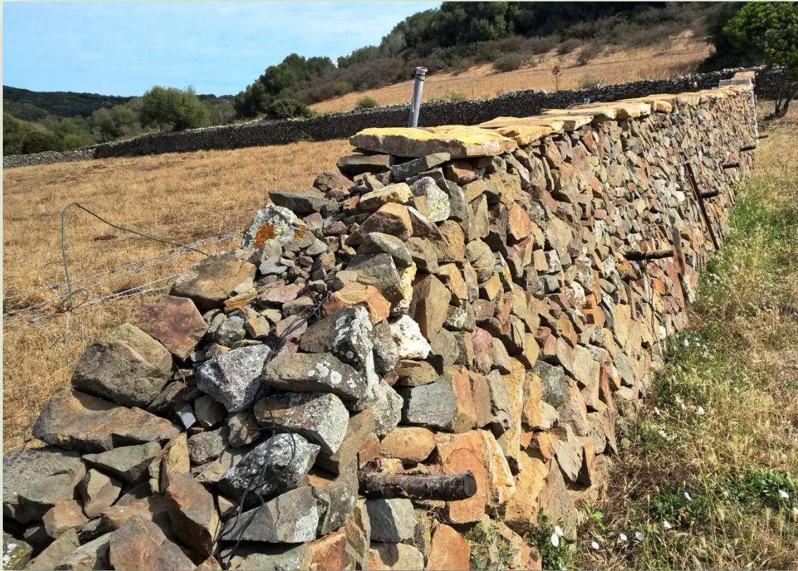
Part de paret reconstruïda amb cobertura de lloses, amb estaquetes d'ullastre inserits a la mateixa, per recolzar-hi les canonades per al reg d'auxili a l'horta, evitant malmetre-les en llaurar, i part de paret per reconstruir
