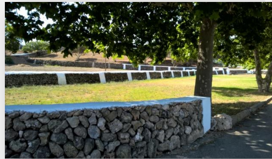
Paret amb cobertora plana d'argamassa
