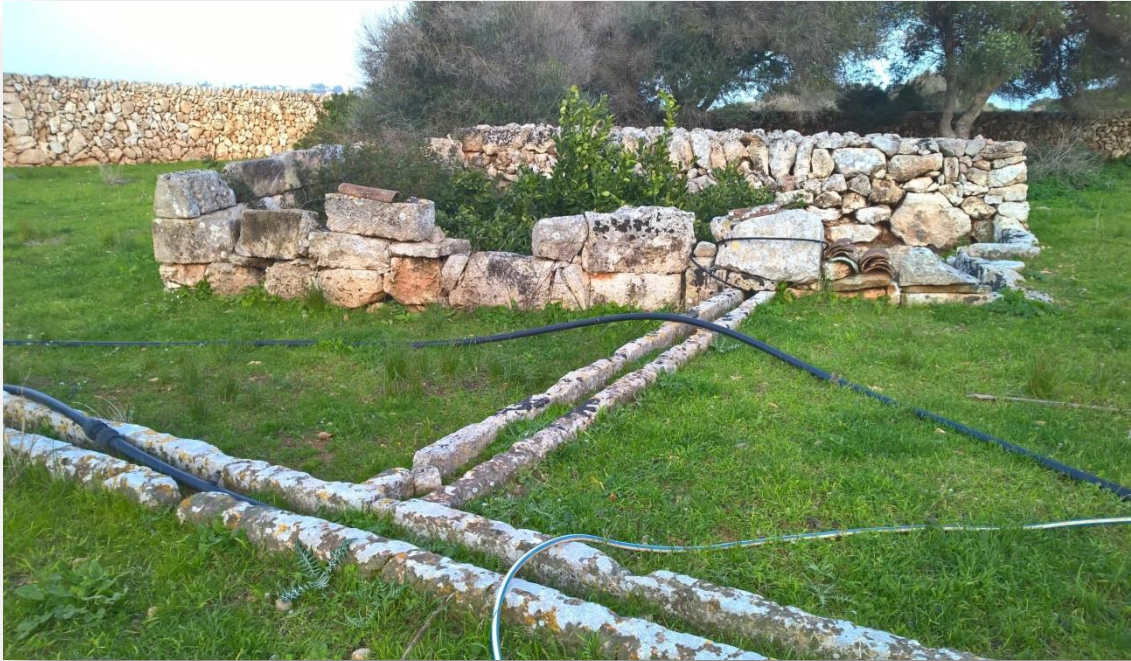
A l'exterior, ben al costat de les cases, s'hi conserven les canalitzacions antigues de regadiu i els corrals per a fruiters excavats per sota del nivell de la terra per tal de preservar-los dels vents
