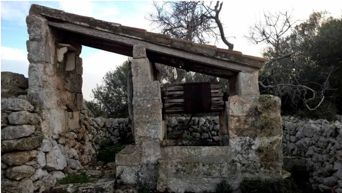
Pou, antiga sínia, amb bomba per extreure aigua
