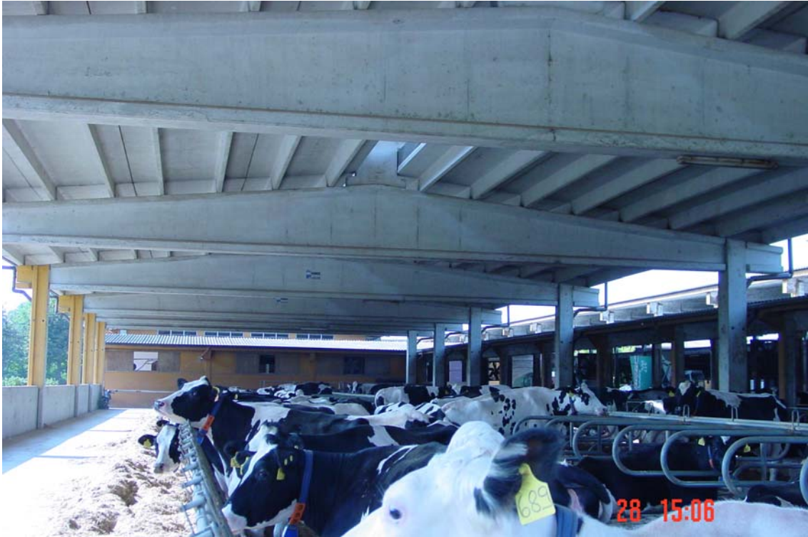
Establació amb cubicles, bigues de formigó
