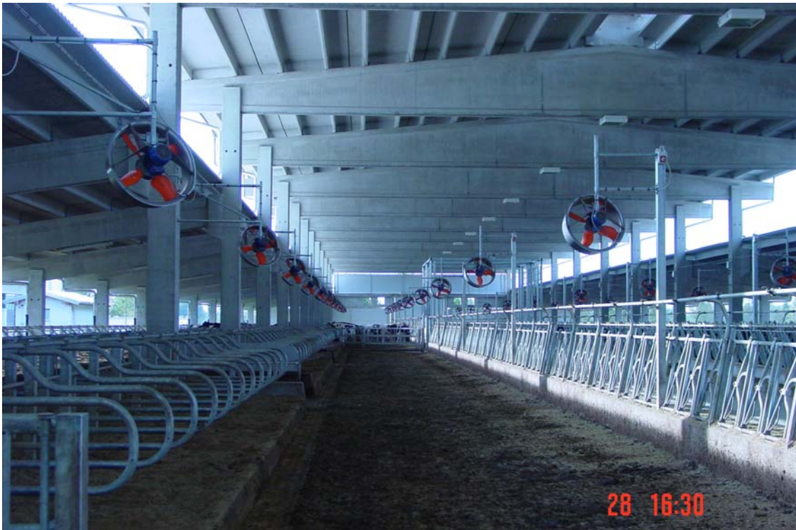
Passadís entre cubicles i menjadora
