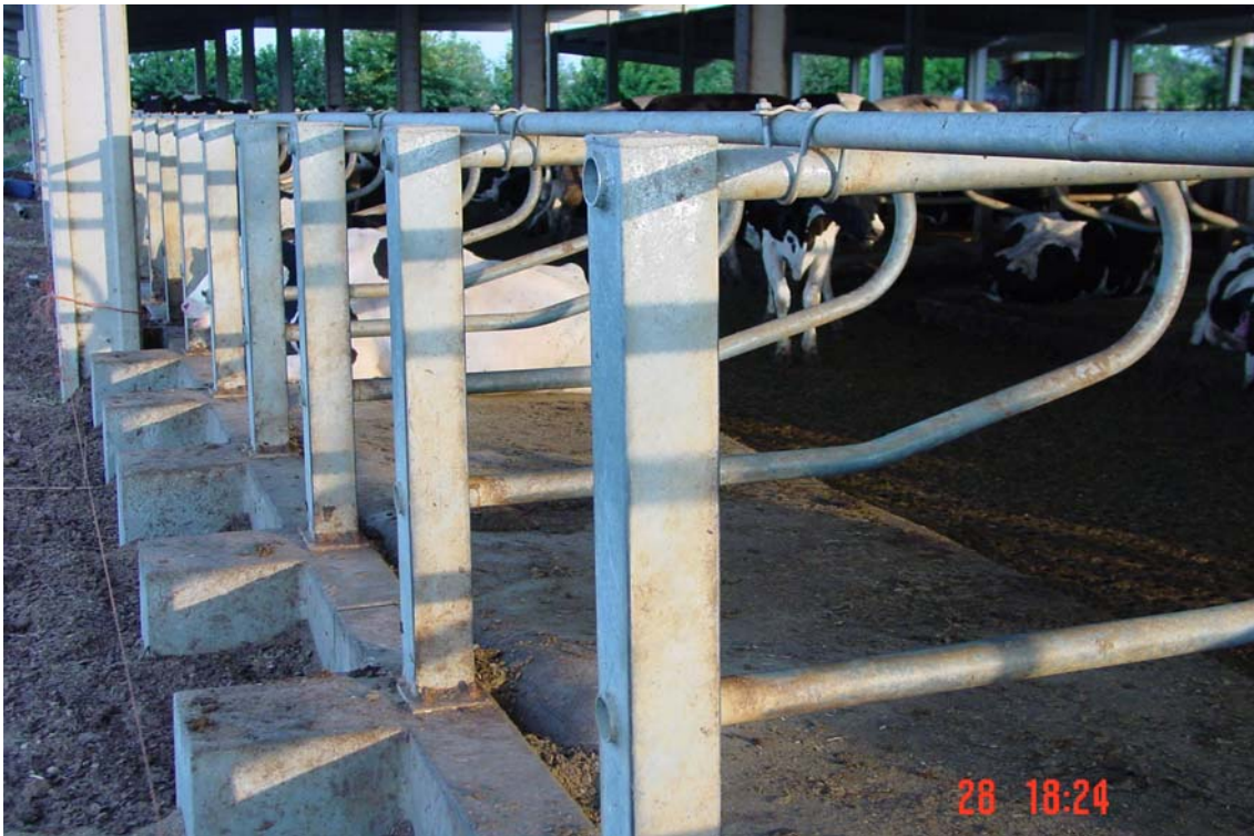
Separador col·locat massa alt des de terra
