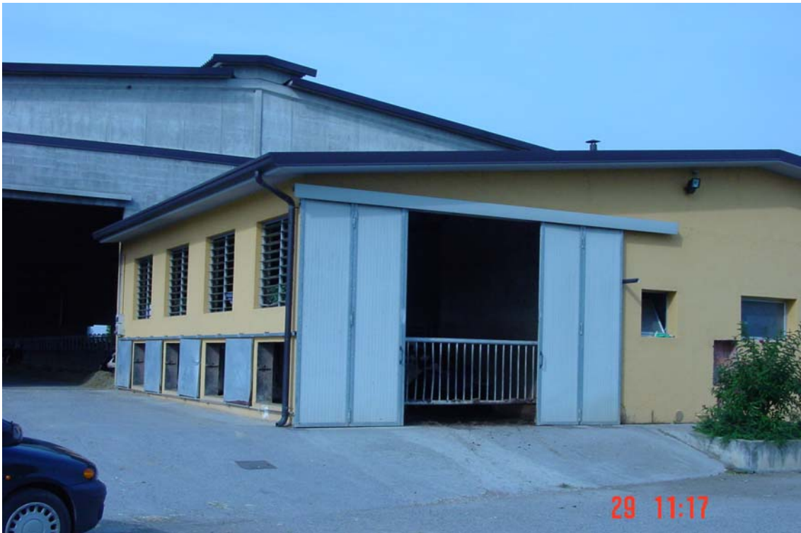
Edifici sala munyir i ampliació menjadora
