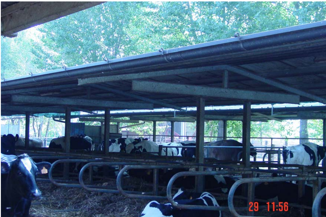
Àrea de cubicles coberta
