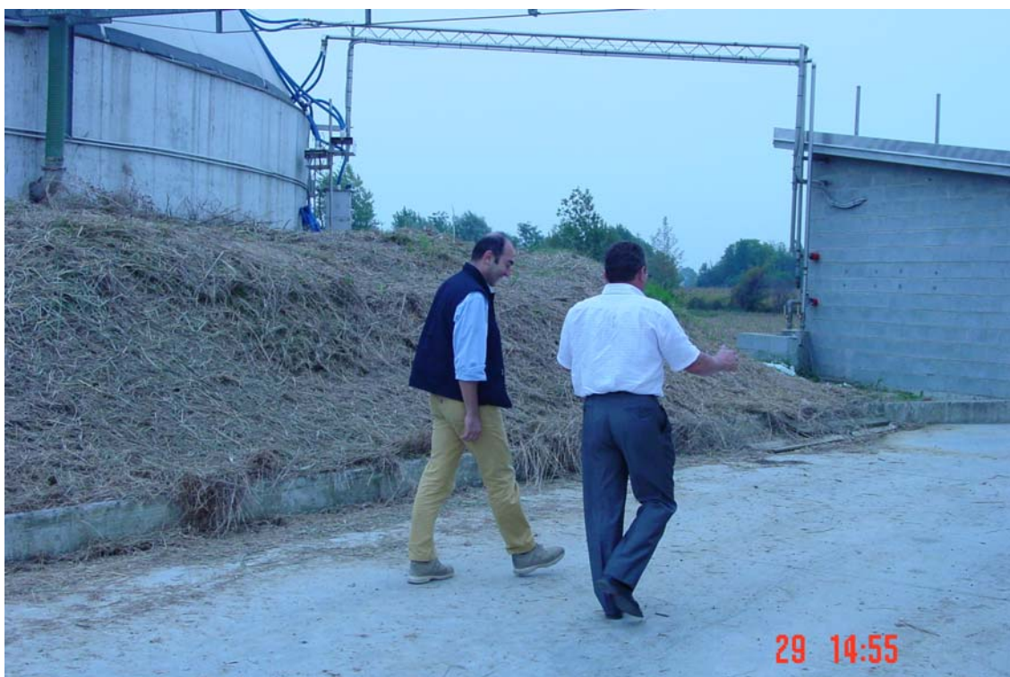
Estabulació amb digestor de gas per fer electricitat
