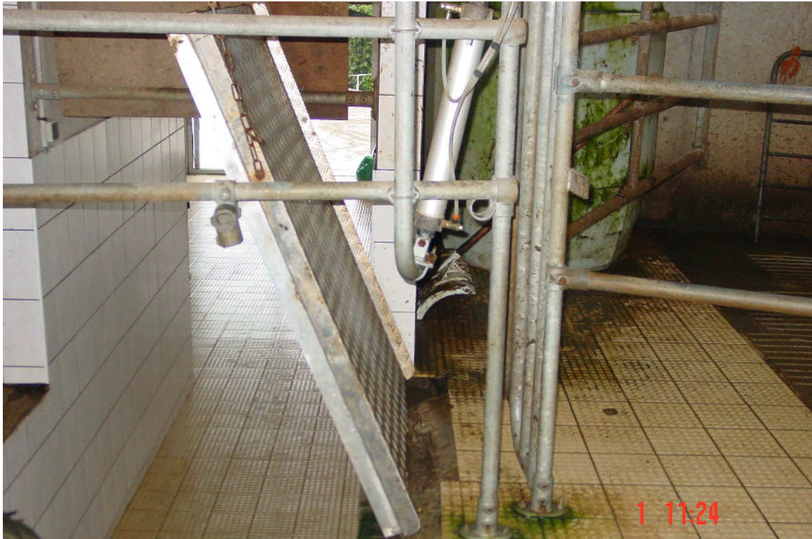
Plataforma mòbil per al pas de vaques a la sala de munyir
