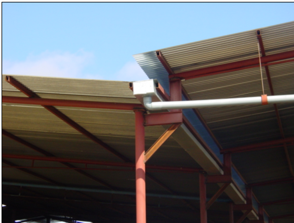
Les estabulacions, tot i la senzillesa, tenen canalització per l'aigua de pluja
