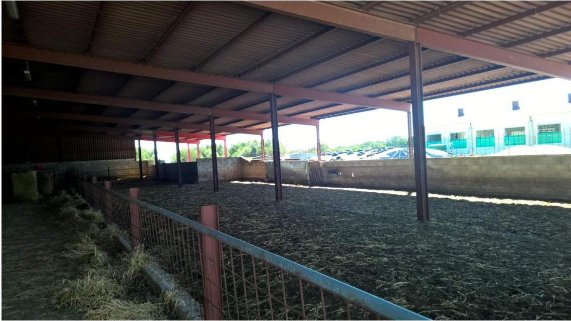
Establació a Alcaidusset per a 130 cabres
