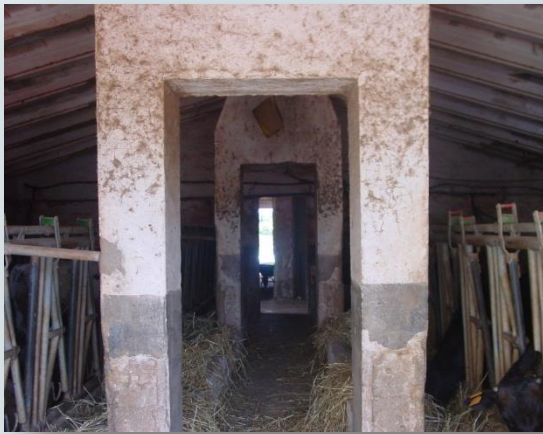
Estabulació antiga on fan la fase final d'engreix
