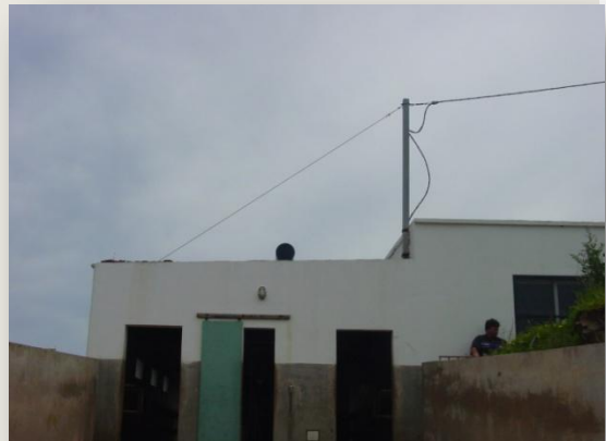
Sala de espera y entradas a la sala de ordeño
