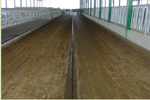
Arrastre deyecciones desde la zona de reposo y alimentación hacia estercolero
