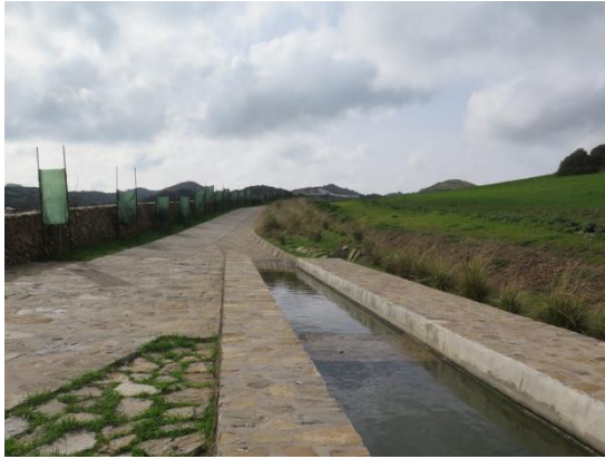
Recogida de agua de lluvia desde la ladera de la subida a las casas
