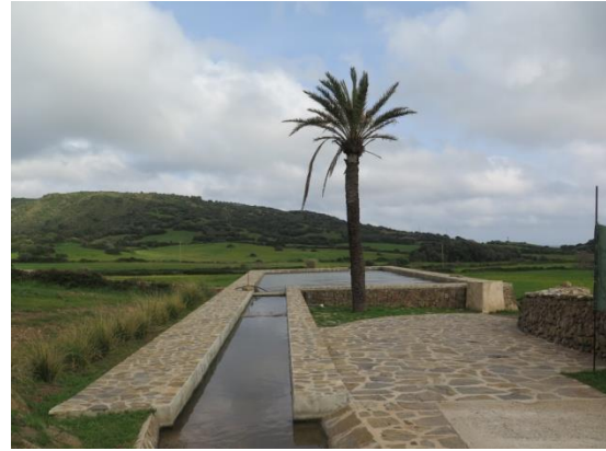
Sistema de esclusas para filtrar el agua que baja de la ladera y entra en el estanque
