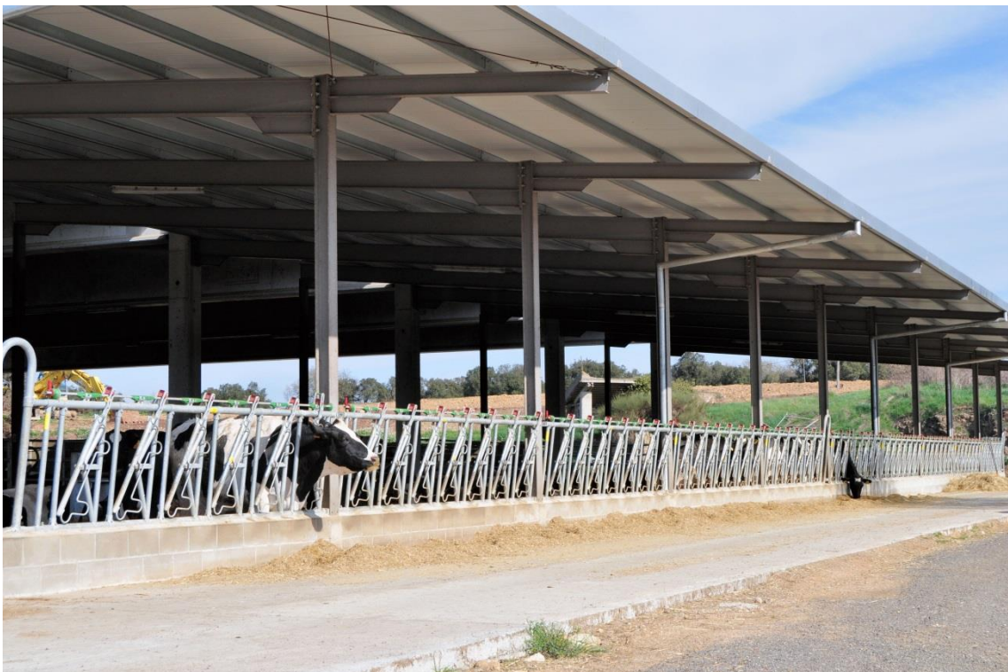
Ampliación de una nave a continuación de la estabulación con cubículos
