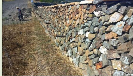
*Pared acabada: base 1 m, altura 1,40 m, anchura cobertera 0,45 m*
