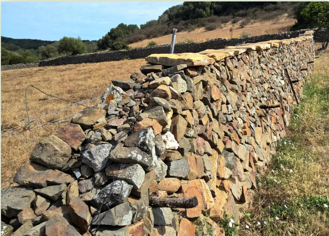
*Parte de pared construida con cobertura de losas, con tabloncillos de acebuche insertados en la misma, para apoyar las tuberías para el riego de auxilio a la huerta, evitando rozaduras en la misma al labrar, y parte de pared para reconstruir*
