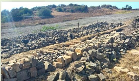
*Se desmontan las diferentes hiladas de la pared y se amontonan en hileras uniformes para distinguir los cascotes, los gujarros, las losas, etc.*
